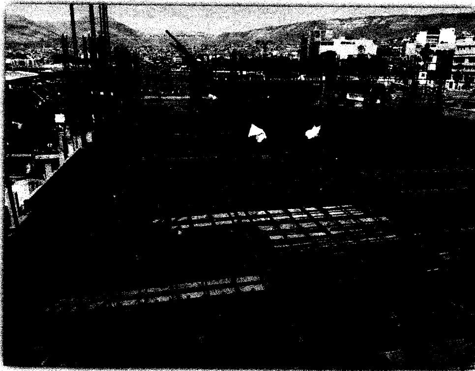
FOTO N°08: Bloque de Fríos: ejecución de la partida de instalación de acero de refuerzo en área de losa maciza.
