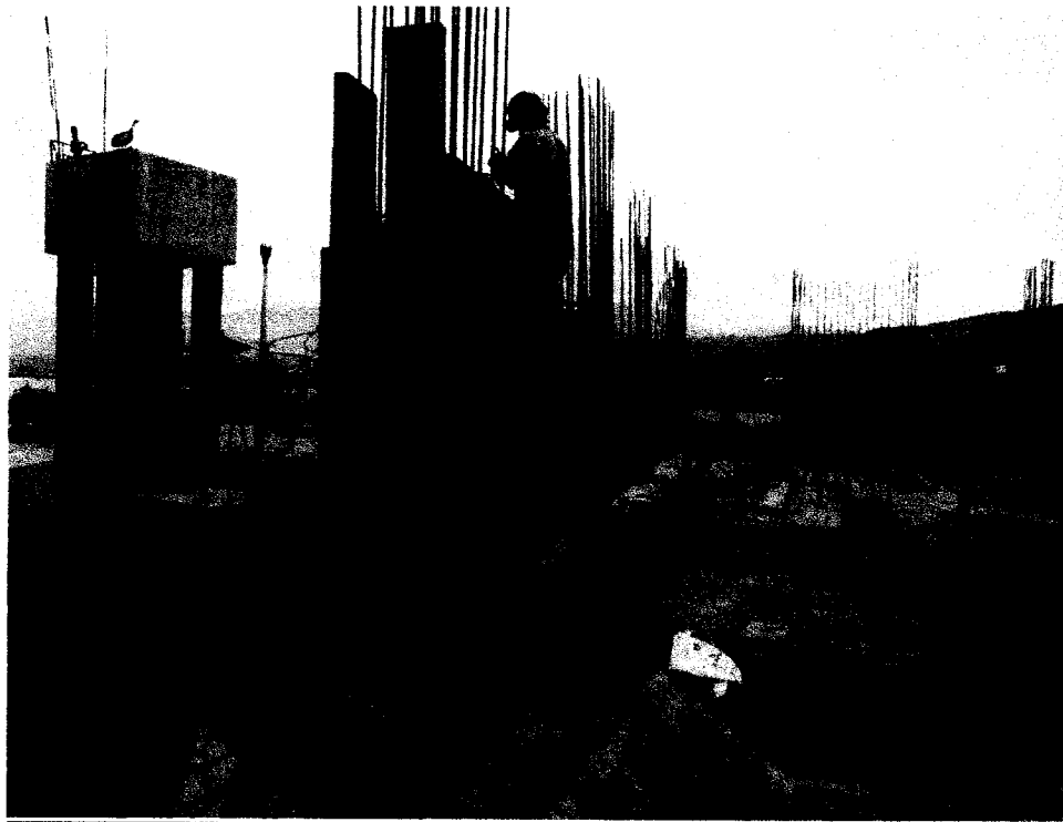
Foto N° 10: Trabajos en el área de Bloque de Frio, ejecución de los trabajos de encofrado de columnas en el segundo nivel.
