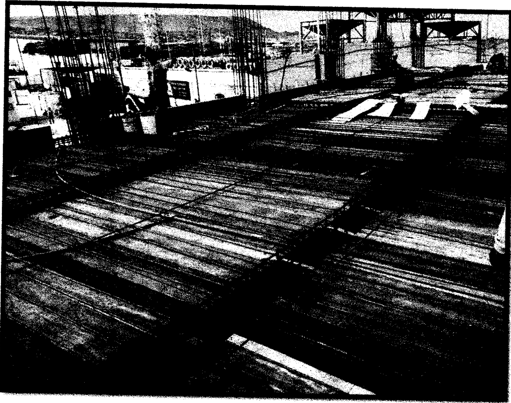
FOTOGRAFIA 01: Encofrado y armado de vigas en losa maciza de área de fríos.
